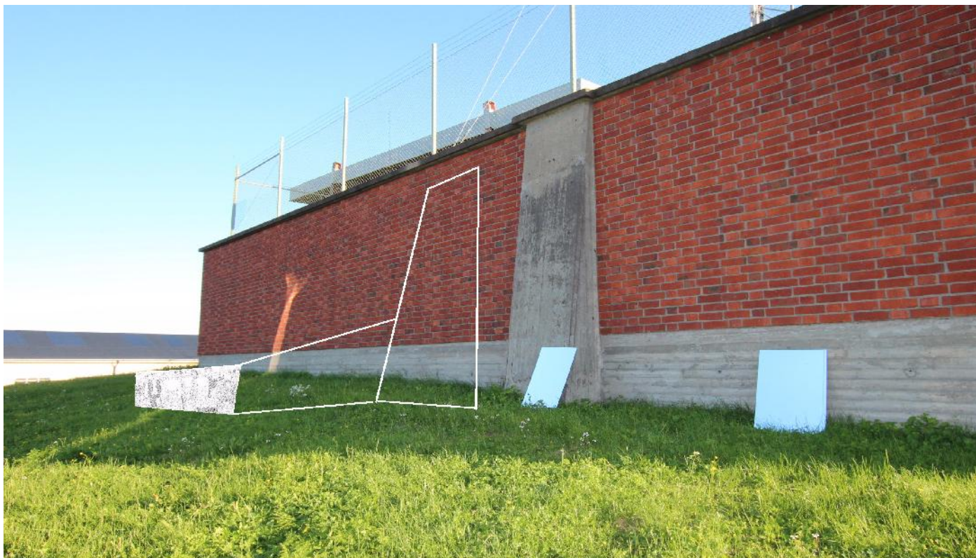
Bild 17. Installation " Föreställningar om gemensamma rum " vid mellanrummet vid Vattentornets baksida.
